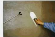
4mm塗厚水打金ゴテ押さえ(4mm工法)
