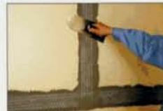
継手ネット張付(スーパーネット)
