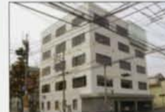
改修工事完成
