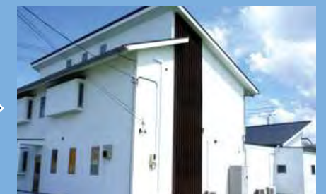
アクリル樹脂系塗料の上にシリコン系塗料で吹き付けリフォーム。
