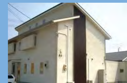
アクリル樹脂系塗料の上にシリコン系塗料で吹き付けリフォーム。
