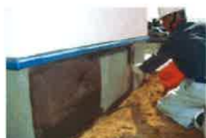
④付属の浸透シーラーを塗布する。
