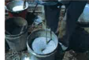
③粉体を入れてさらに攪拌する。 ※水の希釈は約半分程度。 厚塗りの場合は寒水石を入れる。
