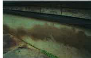
一般的なモルタル刷毛引き仕上げの基礎。湿気の吸い上げなどで汚れが目立ってくる。
