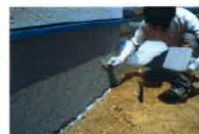
⑥上塗りをする。(仕上げ塗り)
